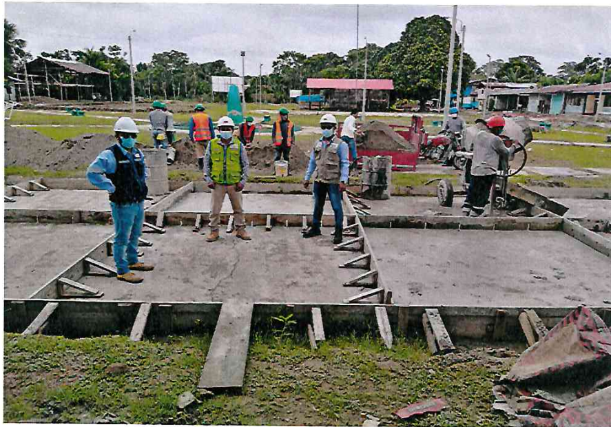
- Verificación y aprobación de los trabajos in situ por parte del Ing. supervisor sobre los trabajos que se realizan a diario en obra.
