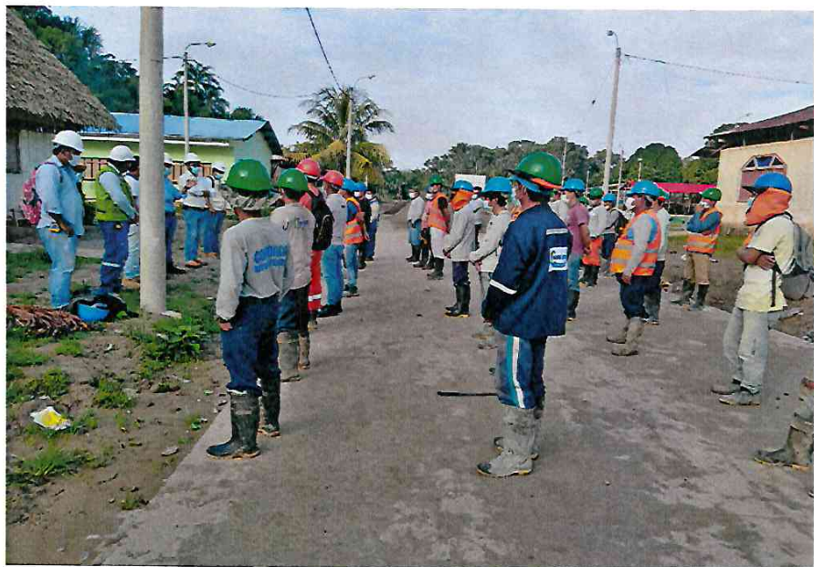
- Charla de seguridad y salud ocupacional, capacitación a todo el personal obrero sobre las partidas que se ejecutaran durante el día.
